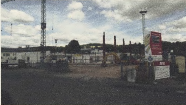
Die Baustelle vor wenigen Wochen
